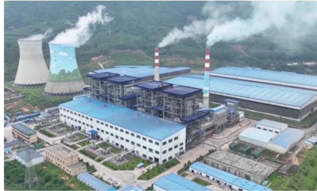
浙江春晖环保能源股份有限公司 2\*130t/h 高温高压生物质循环流化床锅炉。
